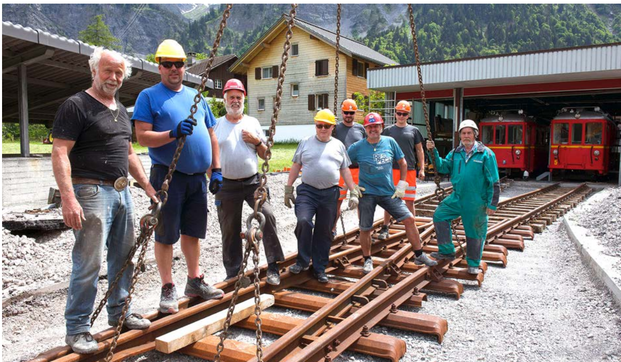
Gleisbau-Team des Vereins Sernftalbahn nach dem Setzen der ersten Weiche am 26. Mai 2020 auf der Nordseite des Depots in Elm. Bild: © Comet Photoshopping GmbH, Dieter Enz
