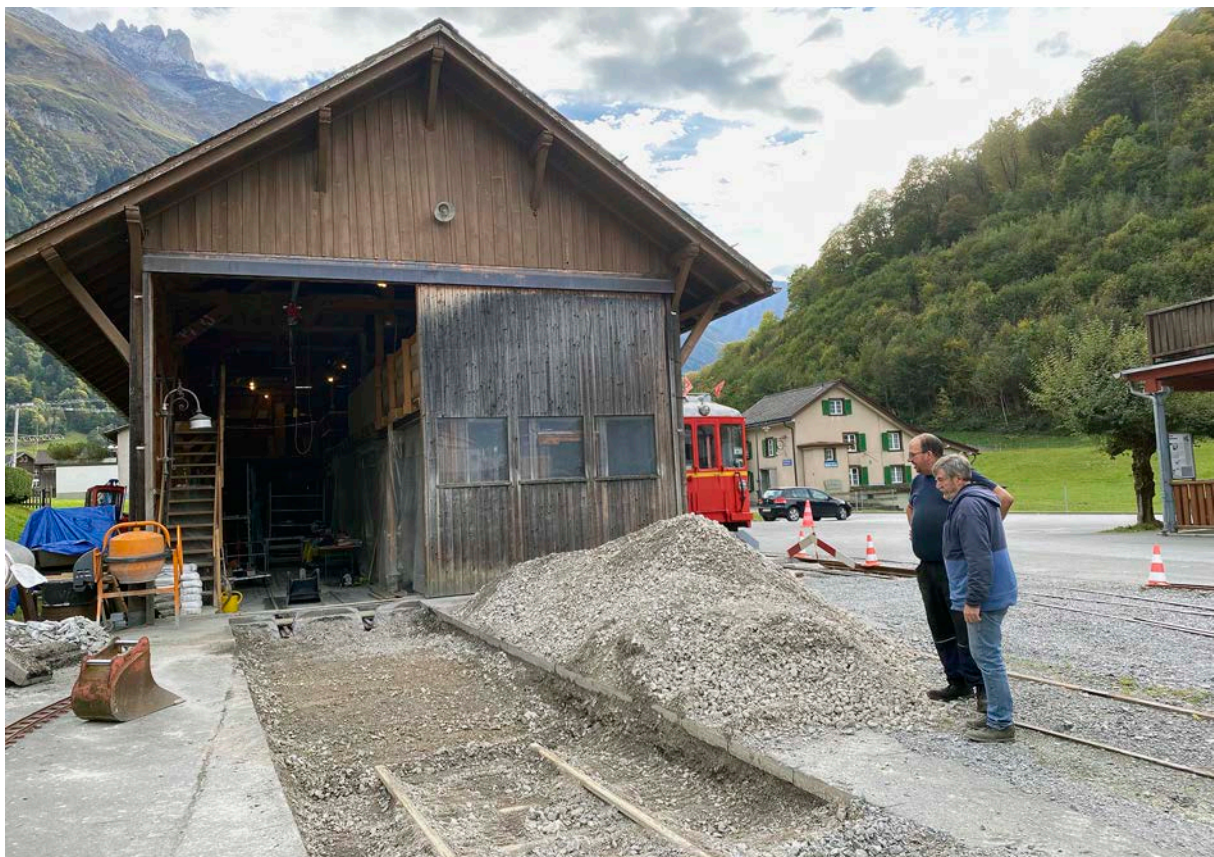
Verbindung zum bestehenden Grubengleis in der Remise: Hans Raveja und Michi Scherrer bestaunen am 18. Oktober den Baufortschritt ihrer Arbeiten. Bild: Comet Photoshopping GmbH, Dieter Enz
