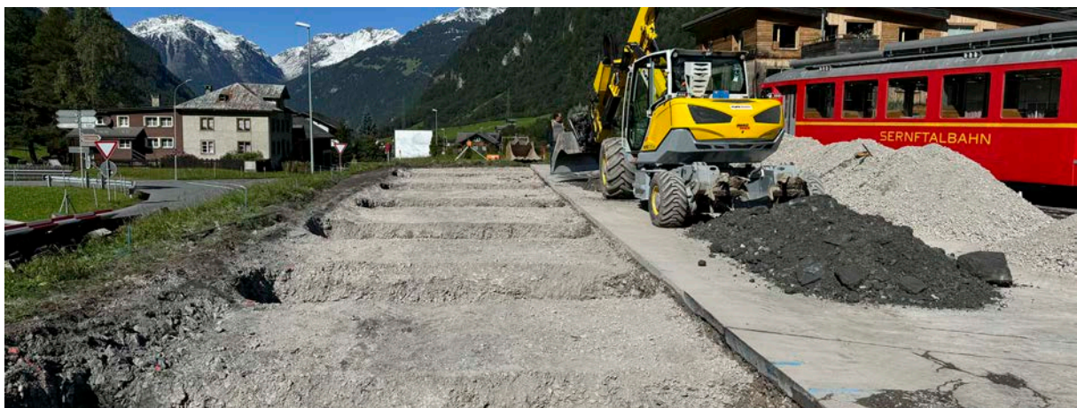
18. Sept. 2024: Der Aushub für die Fundamente des Wagenunterstands ist gemacht. Bild: Mike Putscher
