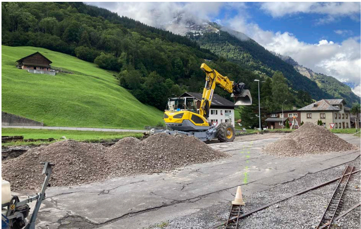
Aushubarbeiten für das Fundament des Wagenunterstands. Bild: Jürg Vögeli
