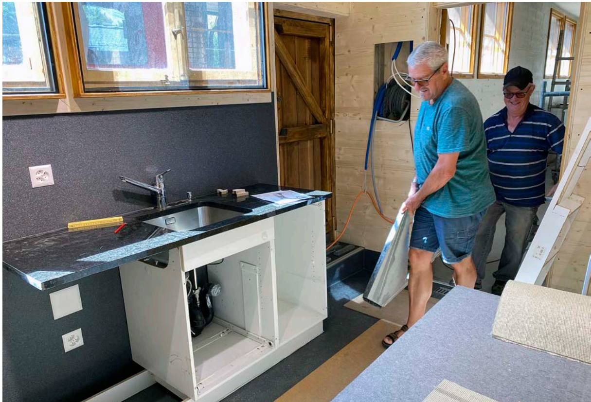
Im Sommer 2024 wird tüchtig am Ausbau der neuen Küche hinter dem Mehrzweckraum in der Remise gearbeitet. Bild: Comet Photoshopping GmbH, Dieter Enz
