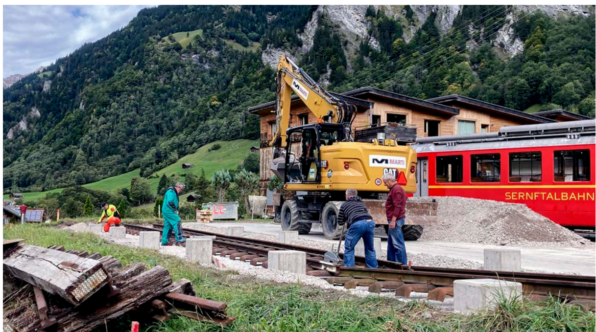
Einlegen der Gleise beim neuen Wagenunterstand in Elm. Bild: Jürg Vögeli
